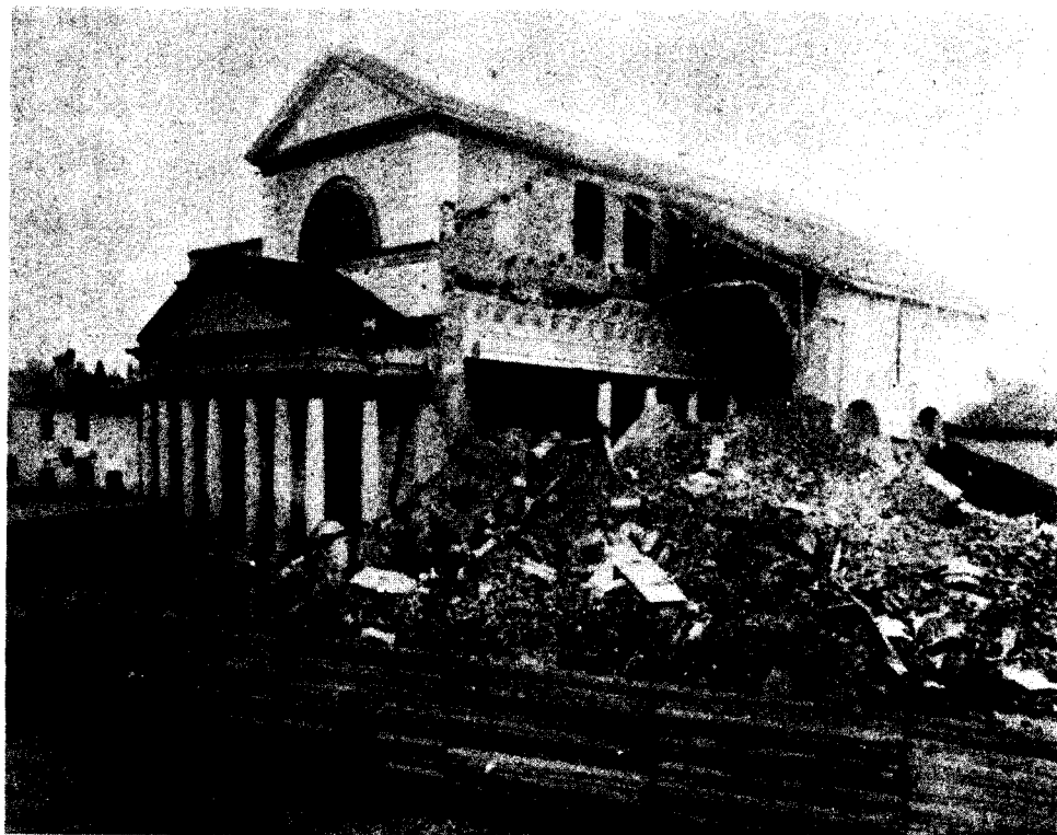
Due giorni dopo il crollo del campanile: 4 giugno 1902.
